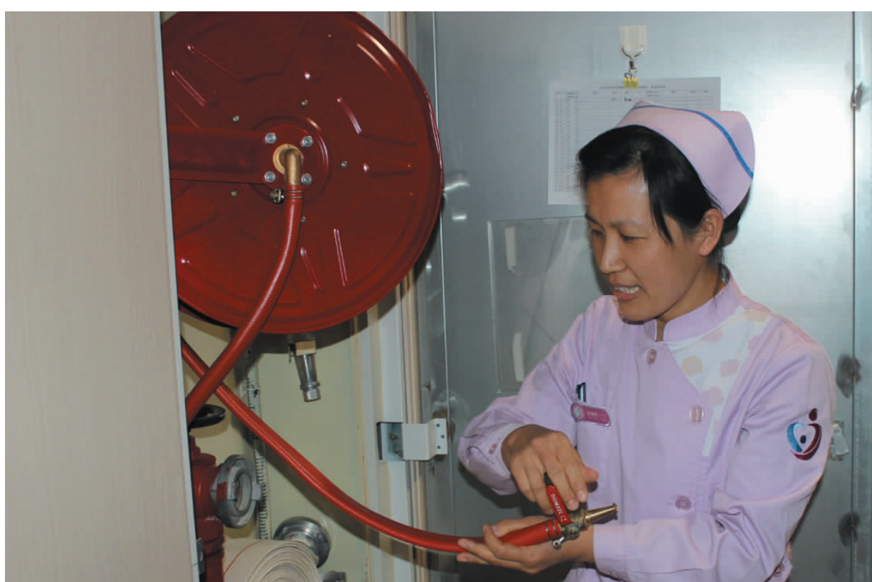
近日，我区某医疗单位工作人员现场演示消防设备的使用方法。
