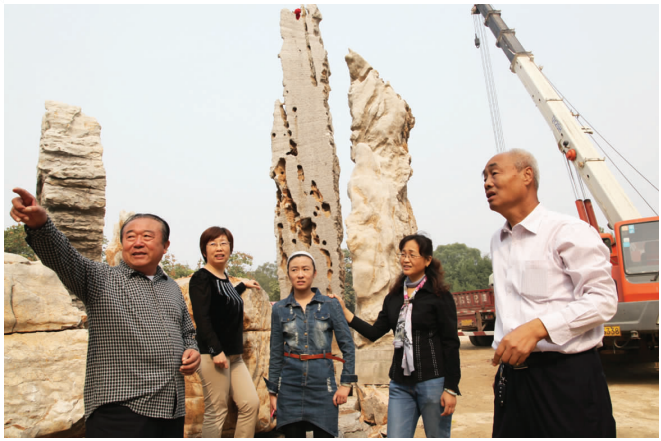
姜堤乐园董事长李士恩在水上石林施工现场。
